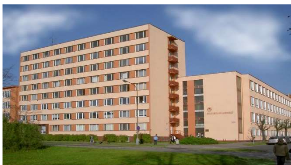
hlavní budova školy U Borského parku 3, Plzeň
