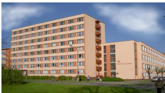
hlavní budova školy U Borského parku 3, Plzeň
