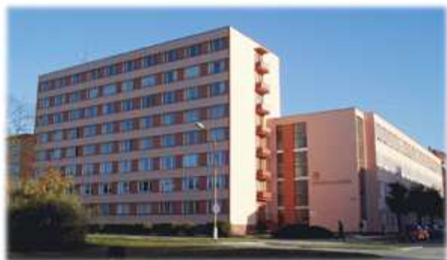
hlavní budova školy U Borského parku 3, Plzeň
